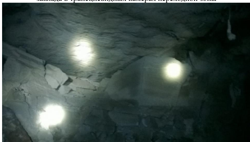
Рисунок 10 – Заколообразование закладочного массива при наличии недозаклада в трапециевидных камерах переходной зоны
