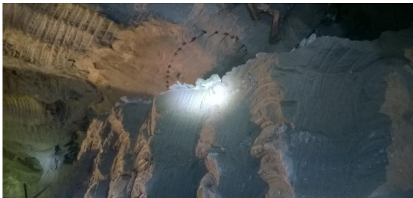
Рисунок 4 – Фото пустот (недозакладов) в выработанном пространстве трапециевидных камер переходной зоны.
