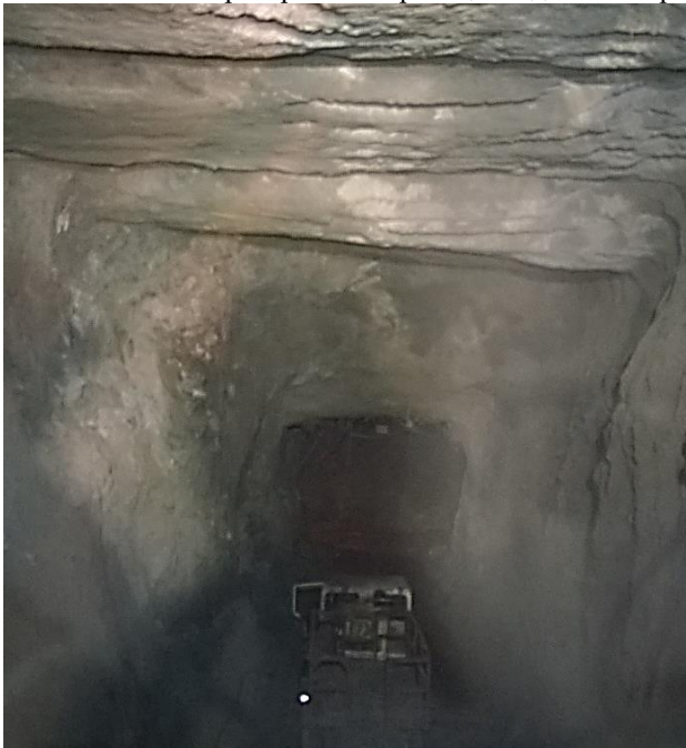
Рисунок 3 – Очистное пространство трапециевидной камеры гор.+70м.
