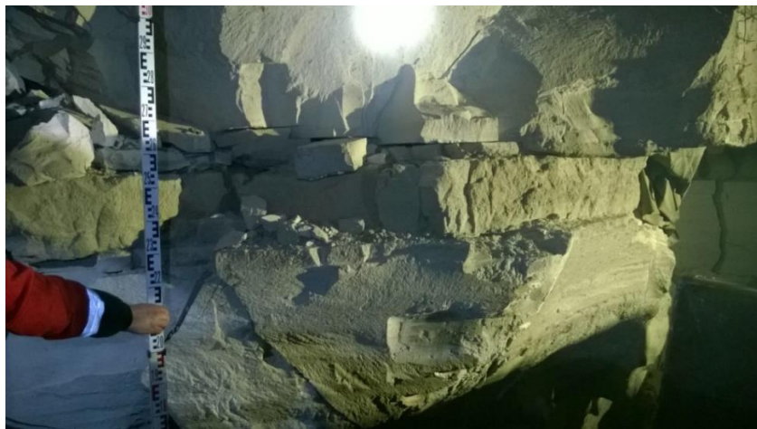
Рисунок 9 – Заколообразование закладочного массива при наличии недо- заклада в трапециевидных камерах переходной зоны
