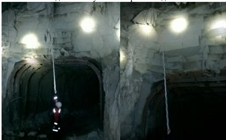
Рисунок 18 – Слоистость несущего слоя и установка рамного крепления на первых метрах буровой выработки
