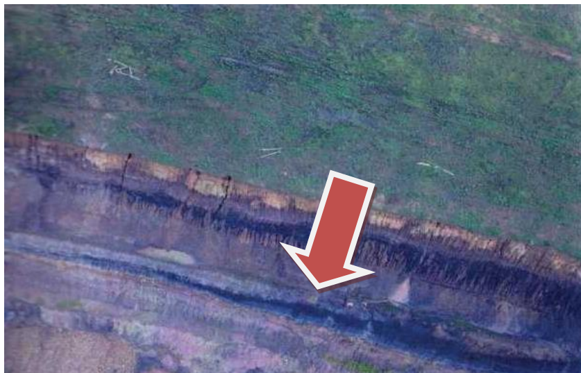
Рисунок 3 – Деформации уступов верхних горизонтов (участок 6, оползень, гор. +200 - +186м, р.л. 36+12м - р.л. 36 +652м)
