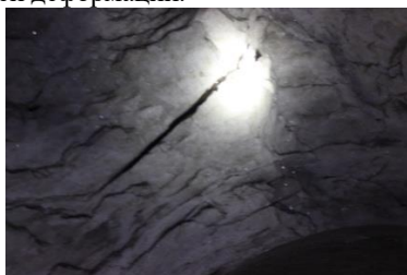
Рисунок 1 – Дугообразные трещины растяжения (растрескивание) в своде очистной выработки
