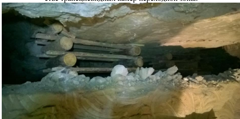
Рисунок 5 – Фото пустот (недозакладов) в выработанном пространстве трапециевидных камер переходной зоны.
