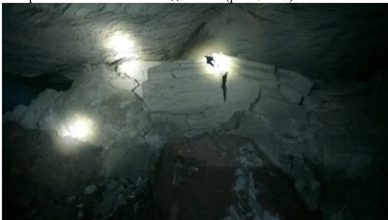
Рисунок 8 – Заколообразование закладочного массива при наличии недозаклада в трапецевидных камерах переходной зоны
