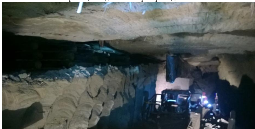
Рисунок 6 – Фото пустот (недозакладов) в выработанном пространстве трапециевидных камер переходной зоны.
